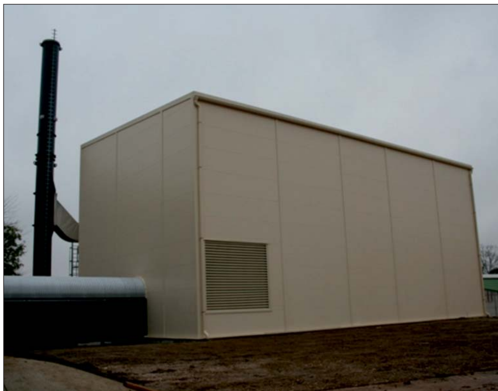
A 8 MW teljesítményű, biomassza-tüzelésű hőközpont
