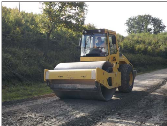
Remixelt pályaszerkezet tömörítése. Fotó: Major László
