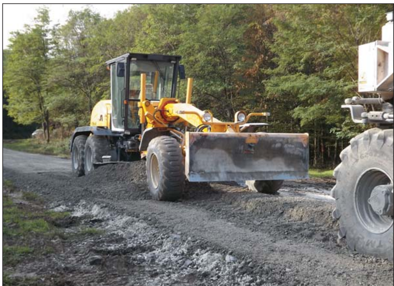
A hideg remix munkafolyamata. Fotó: Sinyi Zsolt
