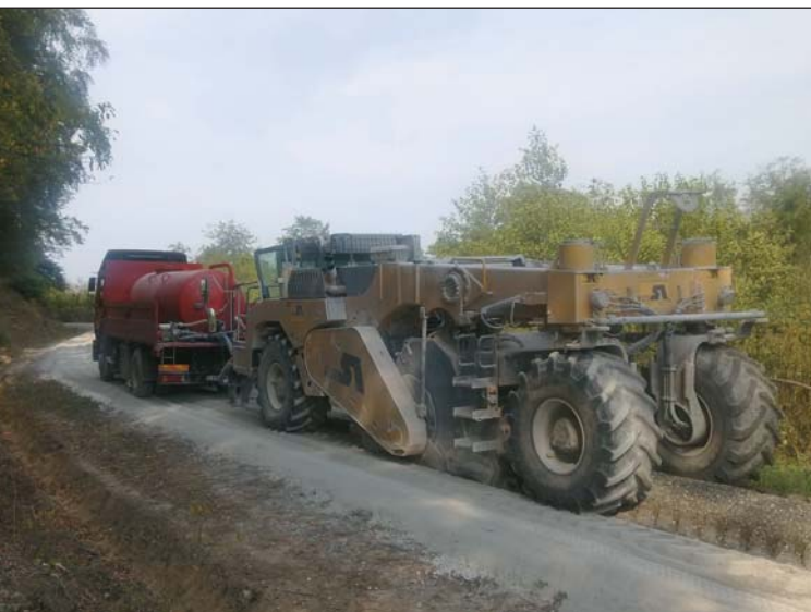
A hideg remix munkafolyamata. Fotó: Sinyi Zsolt
