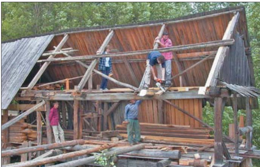
A tetőszerkezet javítása
