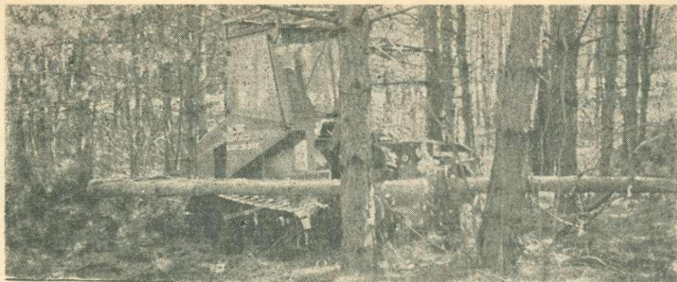
A MAKERI gallyazás-darabolás közben
