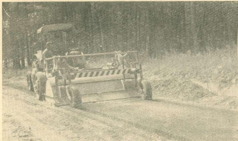
A pulvimixerrel porított és mésszel összekevert talajréteg kialakítása
