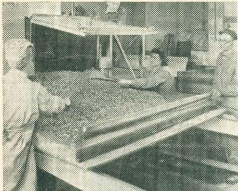
2. ábra. A kísérleti üzem automatikus billenésű keverőgépe, a terítőasztal kocsijával és ráájával
