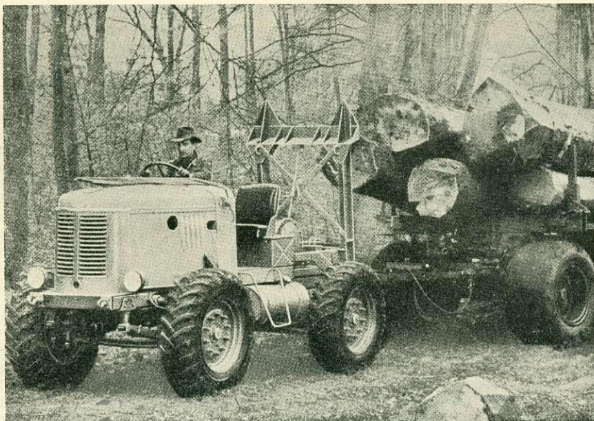
LATIL 4 kerékmeghajtásos vontató
