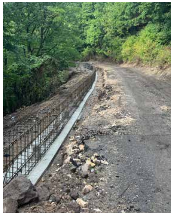
3. ábra „I” jelű mintakeresztmetszvény szerint épülő fejerenda (és az építési területen megjelenő kerékpáros-forgalom)
