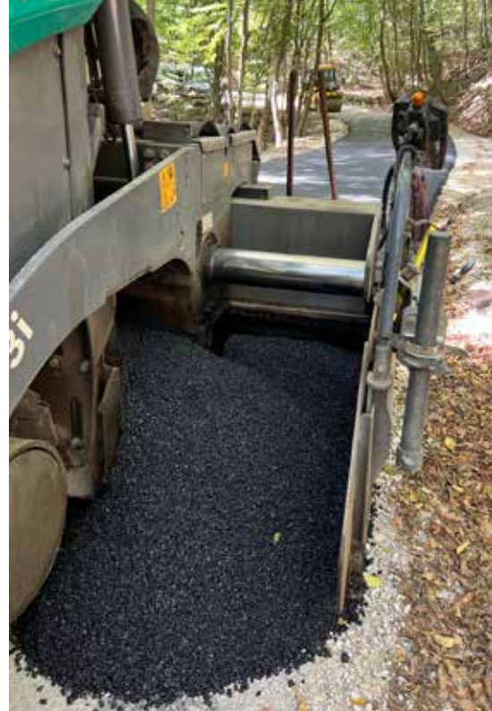
2. ábra „B” jelű mintakeresztmetszvény aszfalttréteg építési munkálatai
