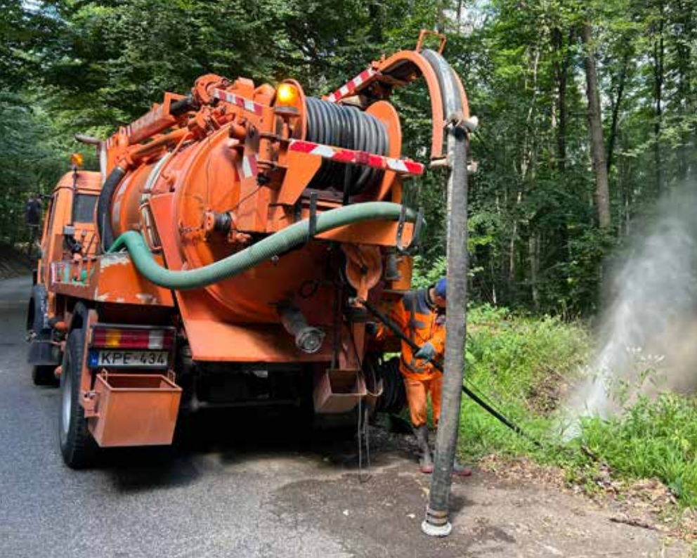
4. ábra Átereszek tisztítása, átmosása
