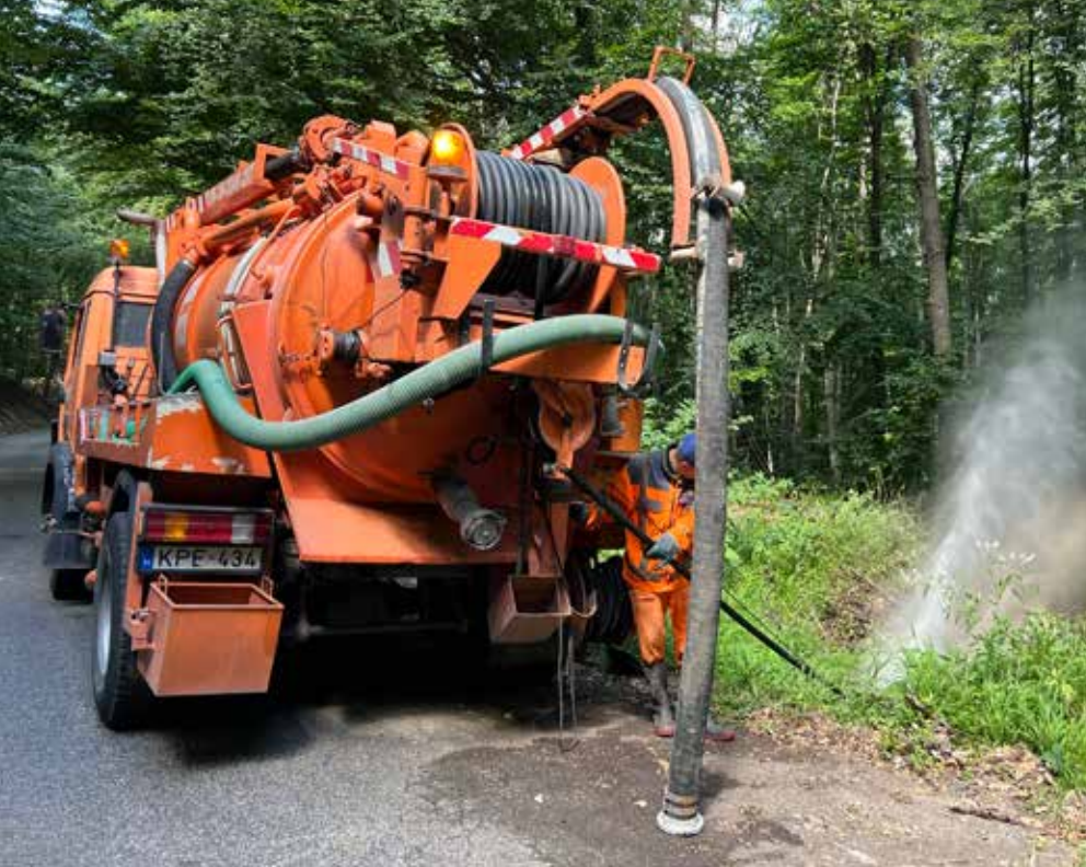
4. ábra Átereszek tisztítása, átmosása
