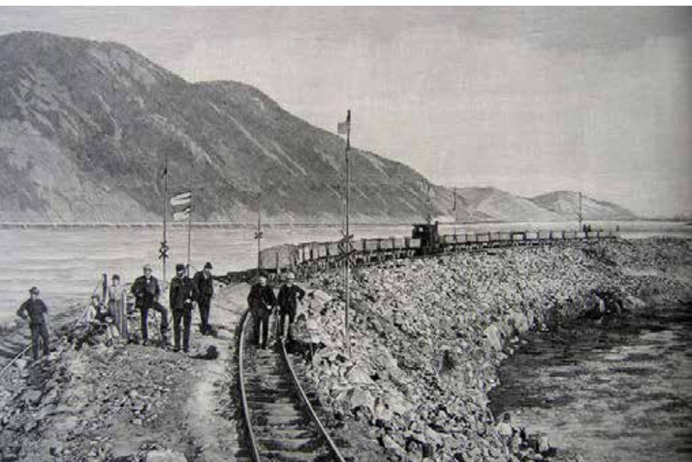
6. kép Medercsatorna töltése a Vaskapu szabályozása során (Forrás: timelord.blog.hu)
