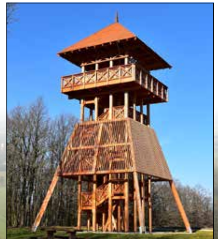
A Scherg Lőrinc-kilátó
