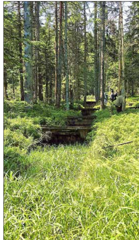
CO 2 megtartás láprekonstrukciós árokrendszer kialakításával
