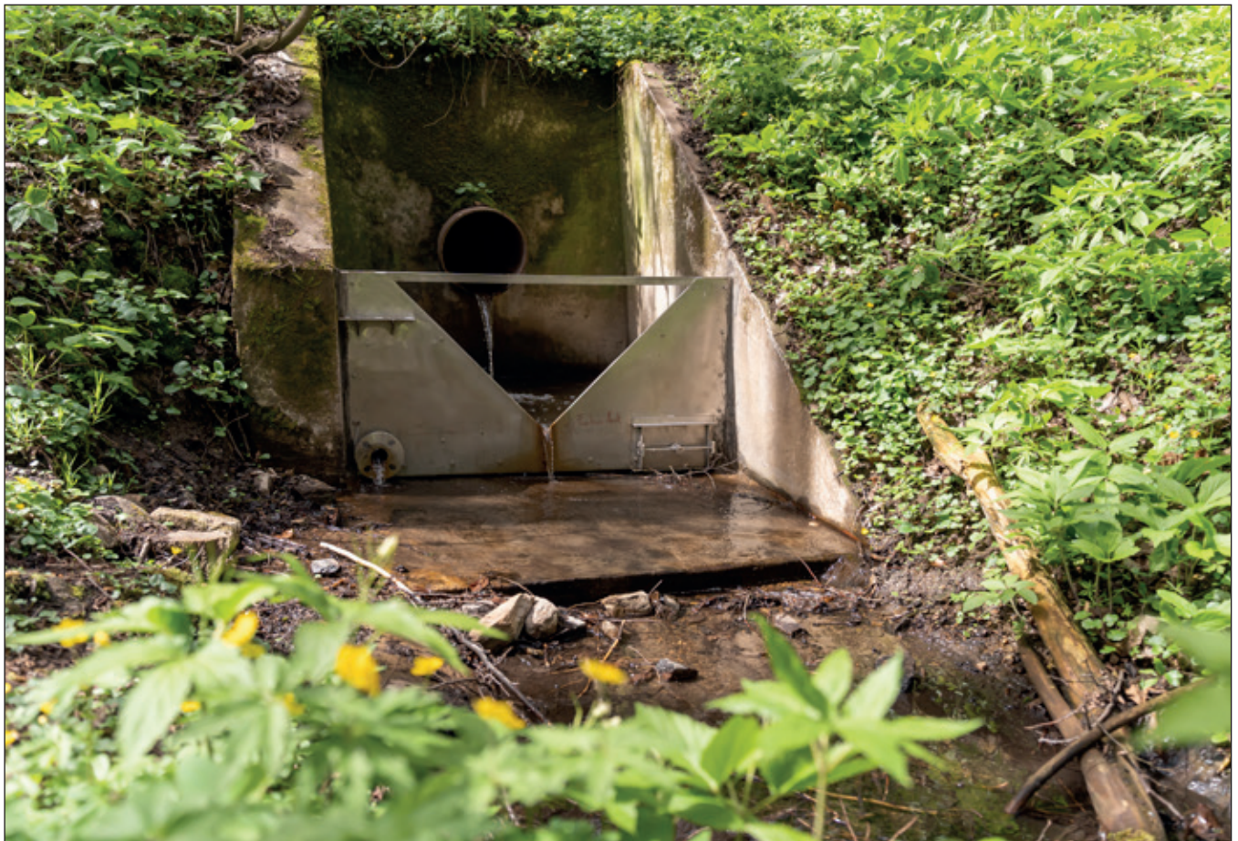
Vízhozammérés kisvízgyűjtőn – Sopron, Hidegvíz-völgy, Farkas-árok
