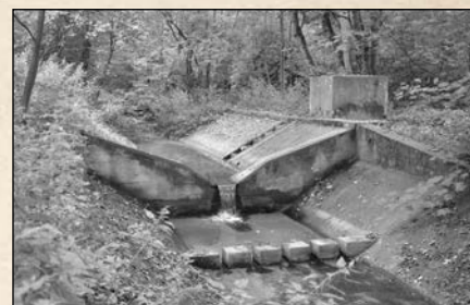
Vízhozammérő műtárgy, Hidegvízvölgy
