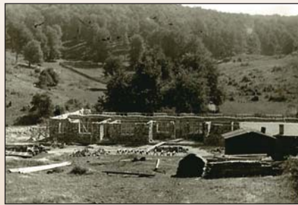
Épül a Hármaskúti Munkásszállás (1953)
