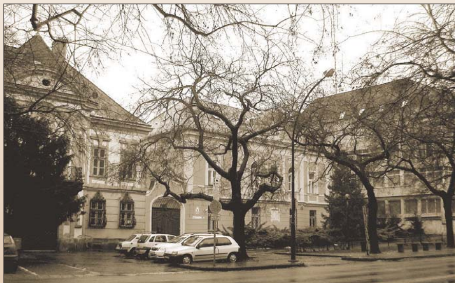
A három erdőgazdasági épület, 1947–1950
