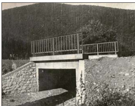
Az Oldal-völgyi híd
