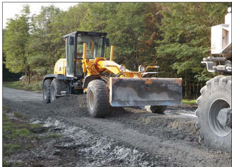
A hideg remix munkafolyamata. Fotó: Sinyi Zsolt
