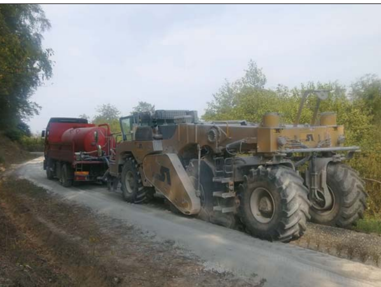
A hideg remix munkafolyamata. Fotó: Sinyi Zsolt
