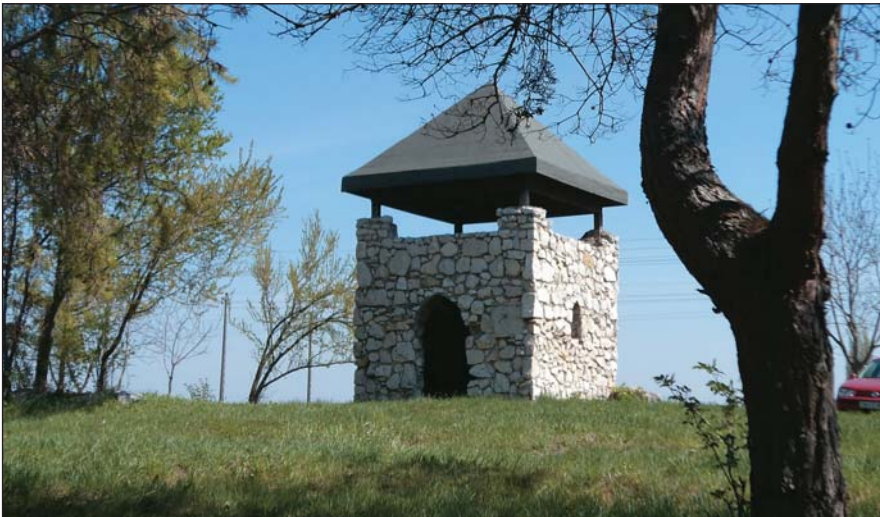
Az együttműködés szép példájaként a fotón a Ráckevei Pereg Parkerdő terméskő kilátója látható. Az erdő ma már országos védettségű természetvédelmi terület, amelynek tervezése és kivitelezése egy igen szép erdőmérnöki-erdésztechnikusi és építészfeladat is volt.
