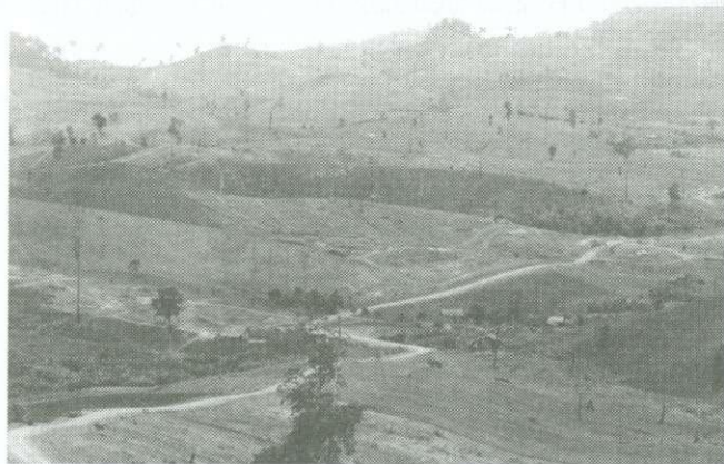
KHAO KHO – Az útépítés után – megkezdődnek a telepítési munkák
