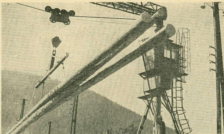
4. ábra: A csehszlovák gyártmányú kábeldaru munkában a Ruzsenberok-i rakodón
