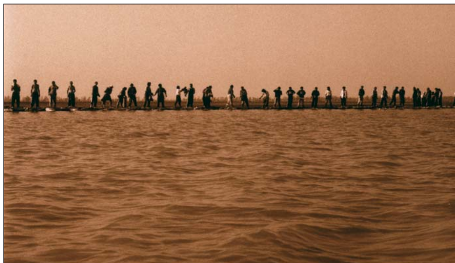
2. kép Nyúlgát építése a Tisza töltésén Tiszajenő térségében – 2000. április (Fotó: Vízzy Zsigmond)
