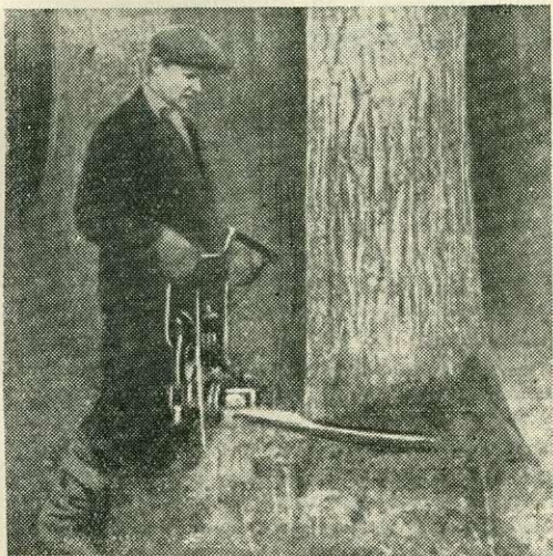
2. ábra : Hajkolás „Druzba” típusú ben- zinmotoros- fűrészszel.
